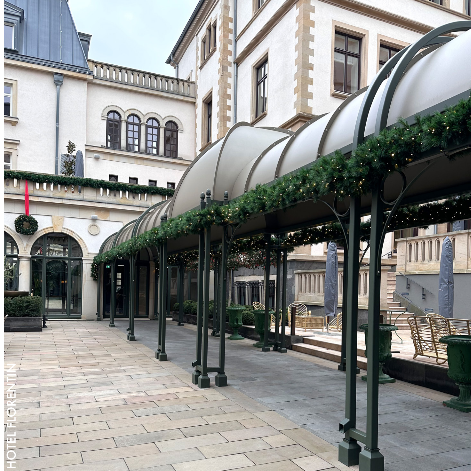
Standort: Frankfurt Sachsenhausen, Deutschland Korrosionsschutz: Feuerverzinkung und Pulverbeschichtung von Stahlstützen und Aluminiumdach Ausführung: ZINKPOWER Meckenheim
