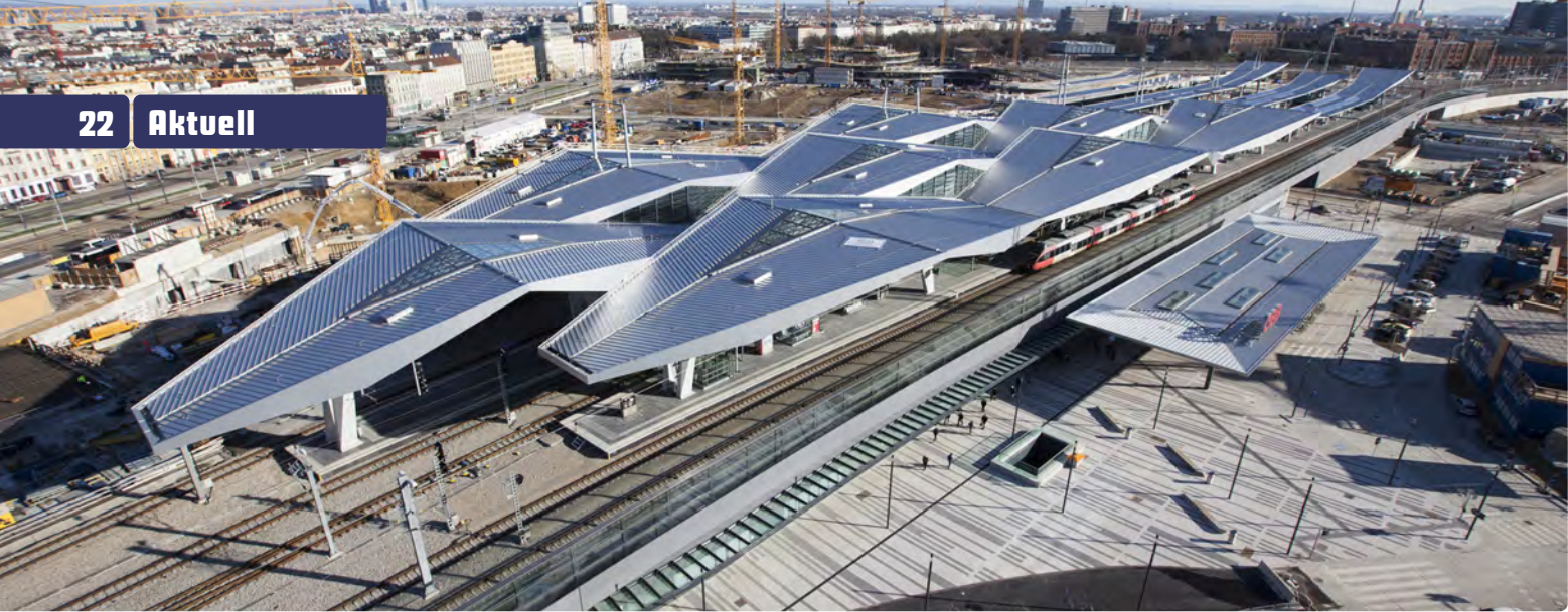
Wiener Hauptbahnhof: Feuerverzinkte Strukturteile bilden die Basis des Rautendaches
