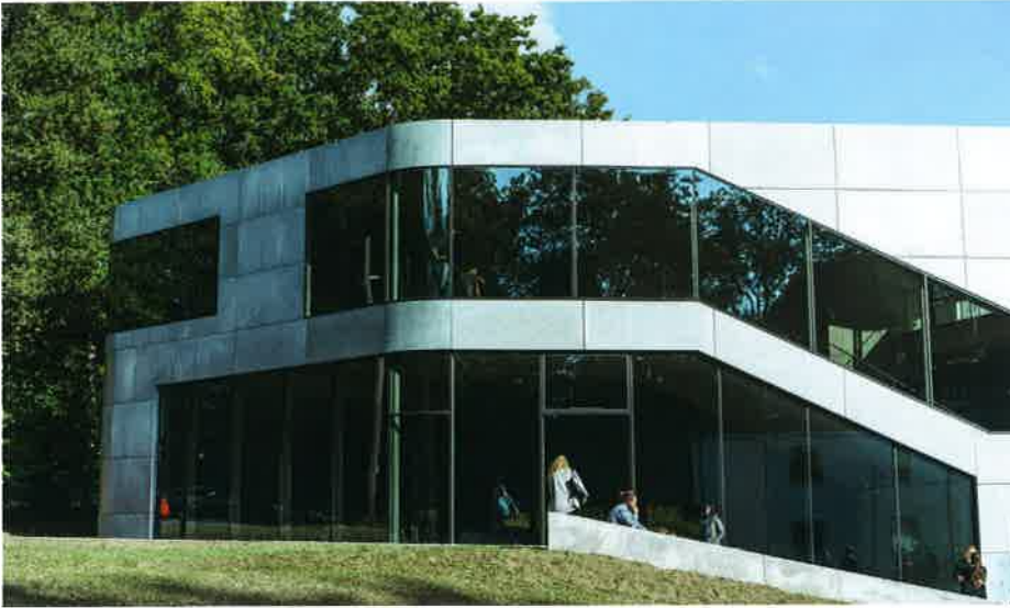
Der ZF Campus der Dualen Hochschule in Friedrichshafen: Viel Glas und Zink bestimmen die Fassadenoptik. | Foto: Maurice Schönen
